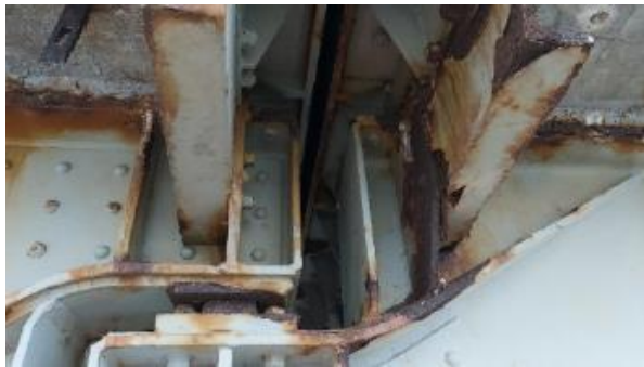
Starr: Bolzenausbildung Einhängeträger
